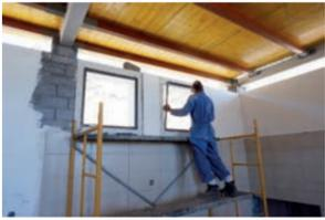
As paredes de bloco prensado foram desenhadas para não necessitarem de reboco externo e interno de modo a minimizar o uso de areia (um material extremamente caro na ilha). Foi substituído por um bloco de acabamento com cal hidráulica e não foram utilizadas tintas plásticas industriais
