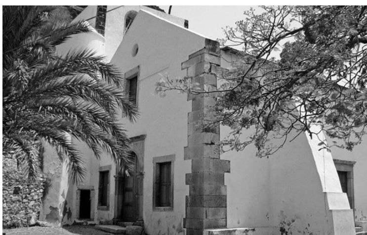
Figura 29_Igreja Nossa Senhora do Rosário pós restauro
