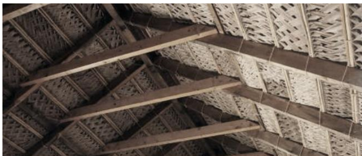
Figura 37_Estrutura de cobertura reforçada com a tecelagem local
