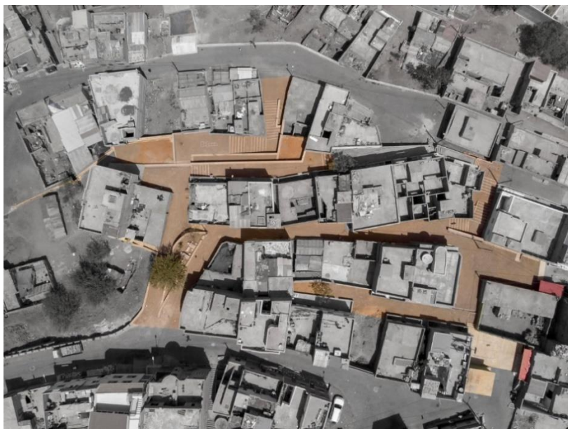
Figura 49_ Vista aérea das zonas reabilitadas
