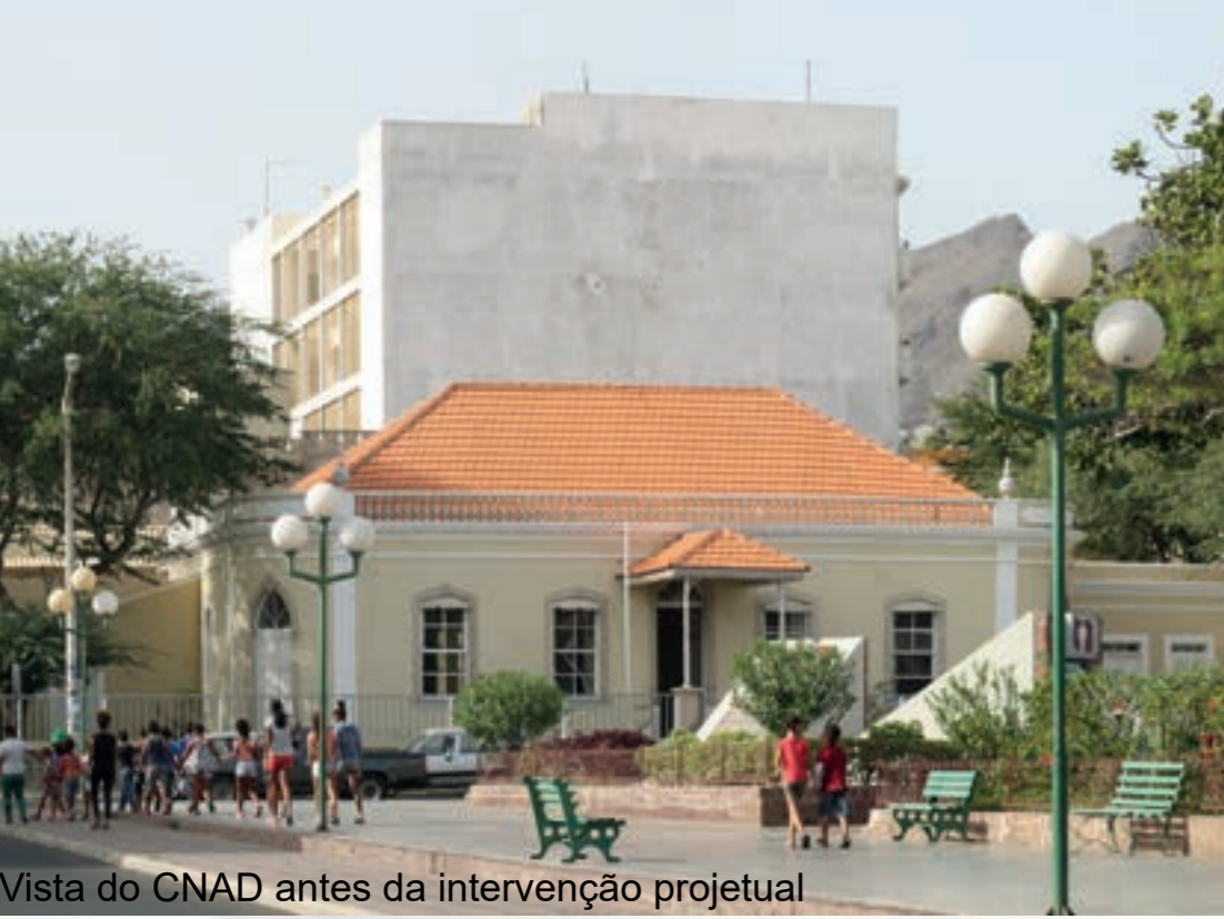
Vista do CNAD antes da intervenção projetual
