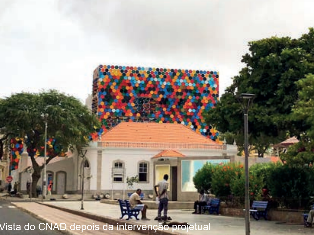
Vista do CNAD depois da intervenção projetual
