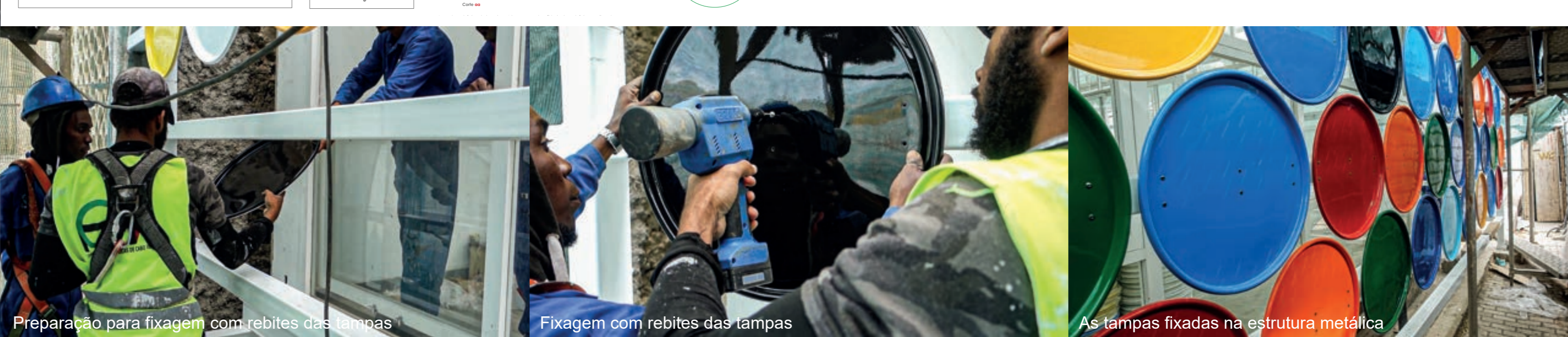
Preparação para fixagem com rebites das tampas
